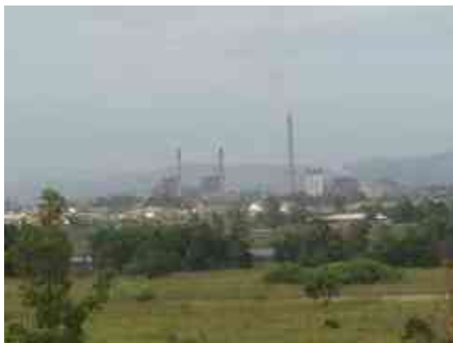
Figura 9: Complexo termelétrico Jorge Lacerda – Capivari de Baixo (SC).
