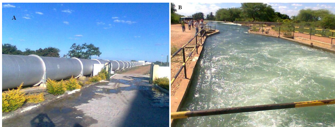
Foto 1: (A) Adutora com 5 km de extensão que deságua em um canal de irrigação de 22 km de extensão, visitada no 2º dia do trabalho de campo. (B) Canal de irrigação visitado no 3º dia do trabalho de campo. Ambos são geridos pela Codevasf. Fotos: Uilliam Lima.
