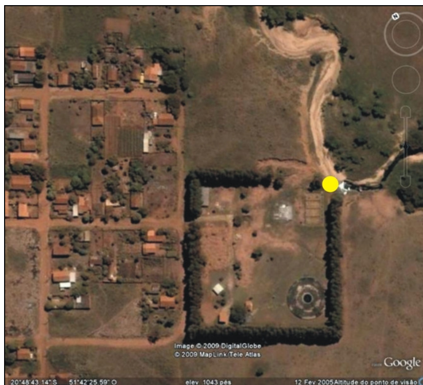
Figura 11. Estação de tratamento de esgoto.
