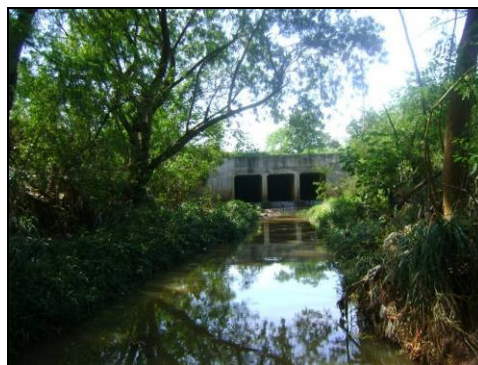
Figura 06. Início da vala aberta Fonte: SILVA, C.H.R., 2009.
